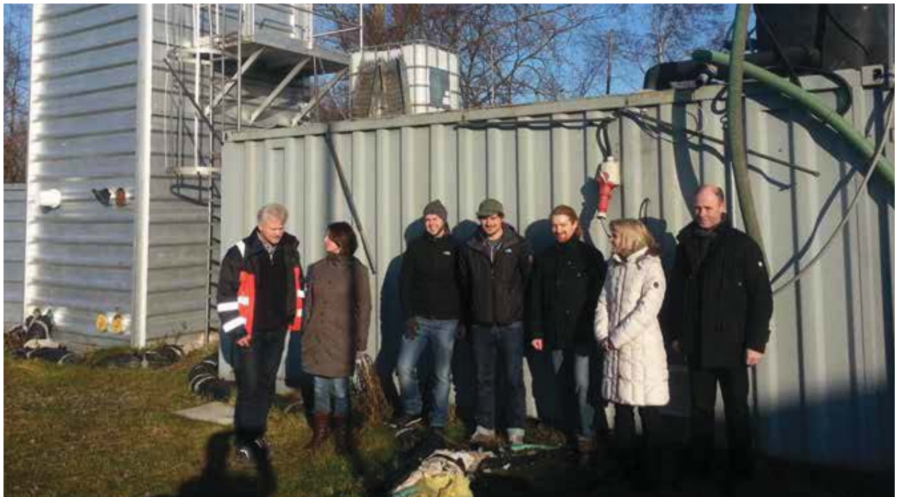
Abb. 1: Pilotanlage auf der Kläranlage Eversburg
