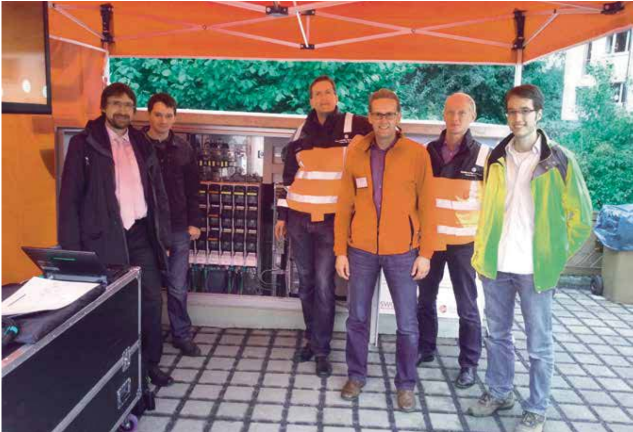
Abb. 1: Mitarbeiter der Hochschule und der Stadtwerke beim Tag des offenen Schaltschrankes der Stadtwerke Osnabrück
