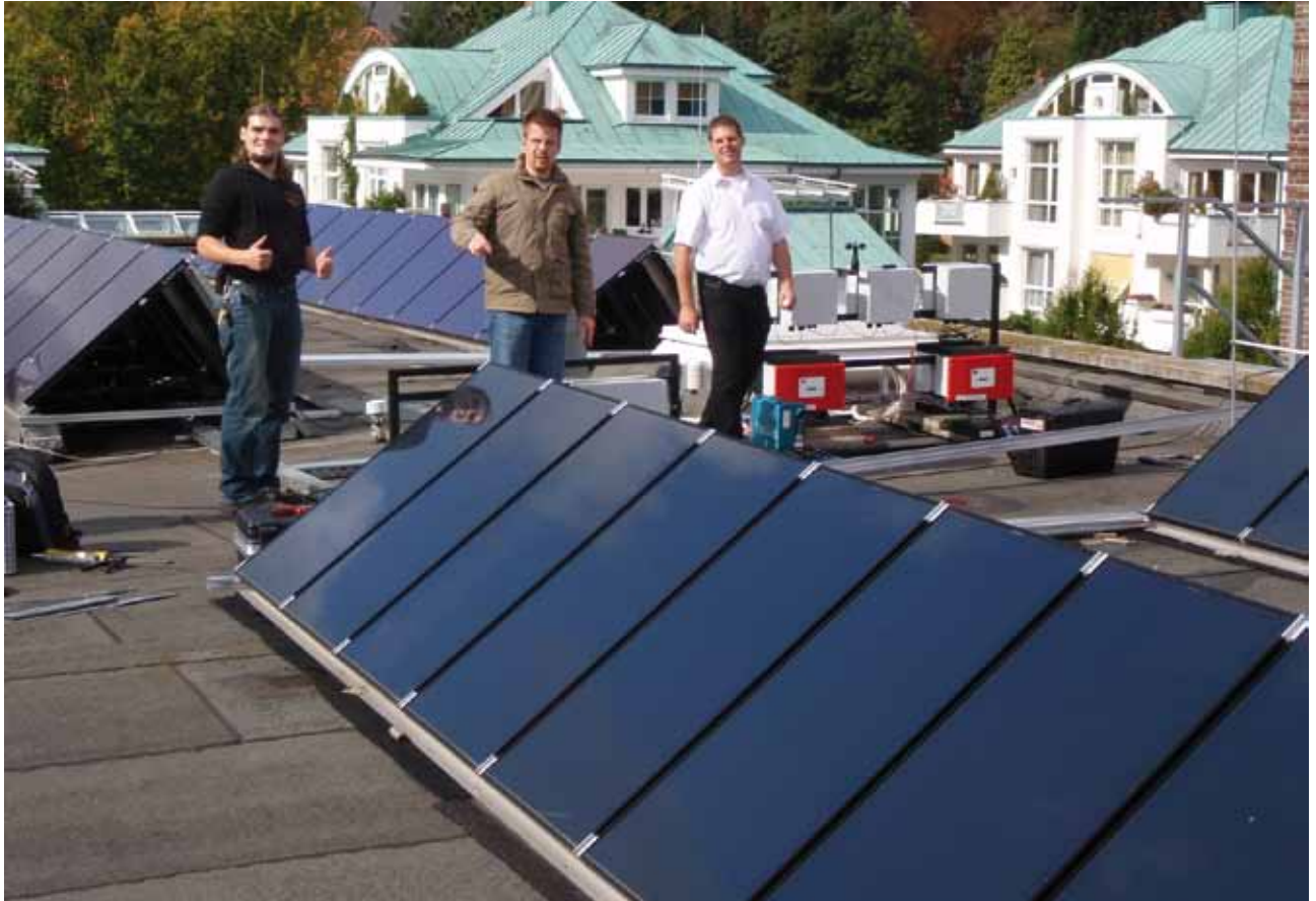
Abb. 1: Wechselrichter sind angeschlossen, Datenleitungen verlegt: Die Sonne kann kommen. Projektmitarbeiter Fabian Albers, Dirk Pohlmann, Jan Harling.
