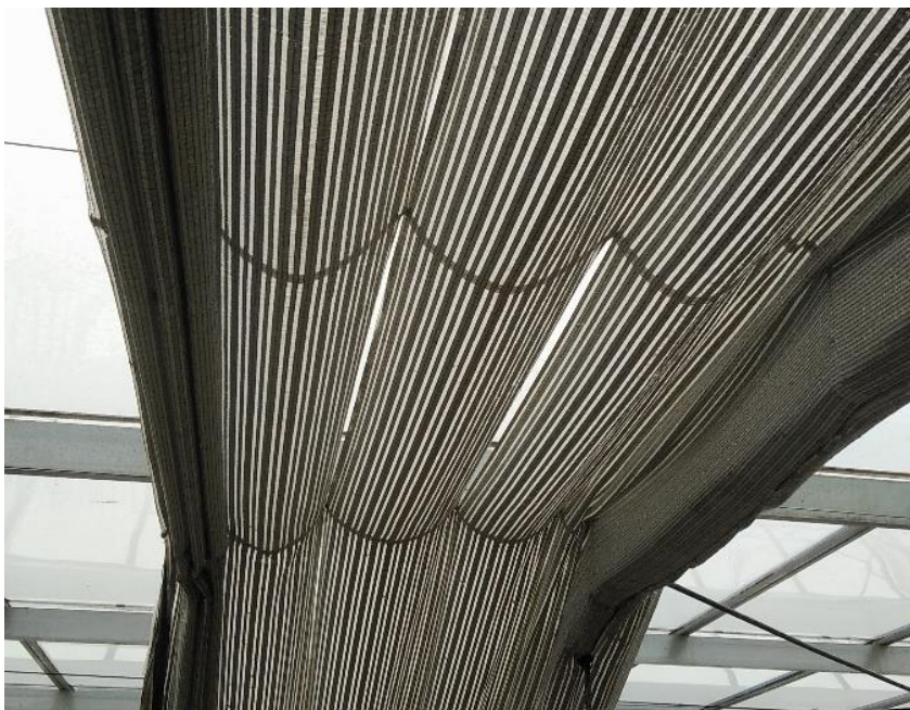
Abb. 1: Schadhafter Energieschirm
