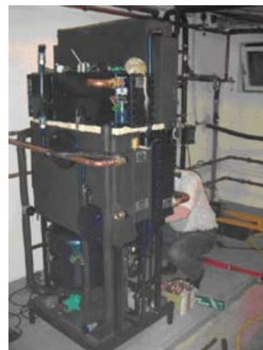
Abb. 2: Die Absorptions-Kältemaschine
