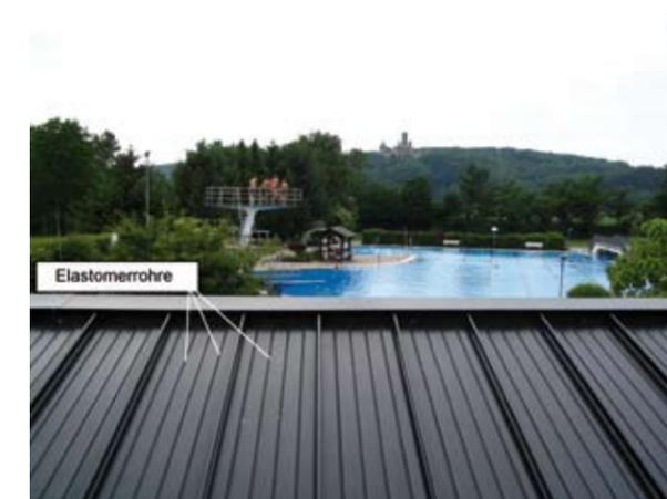
Abb.: Elastomer-Metall-Absorber zur Beheizung des Freibades in Nordstemmen
