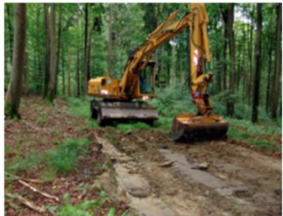
Abbildung 3: Egalisierung mittels Bagger
