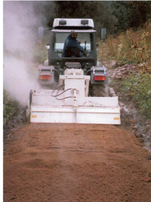
Abbildung 13: Einarbeiten des Kalks auch auf kleinen Flächen. Quelle: Bundesverband der Deutschen Kalkindustrie (2004).
