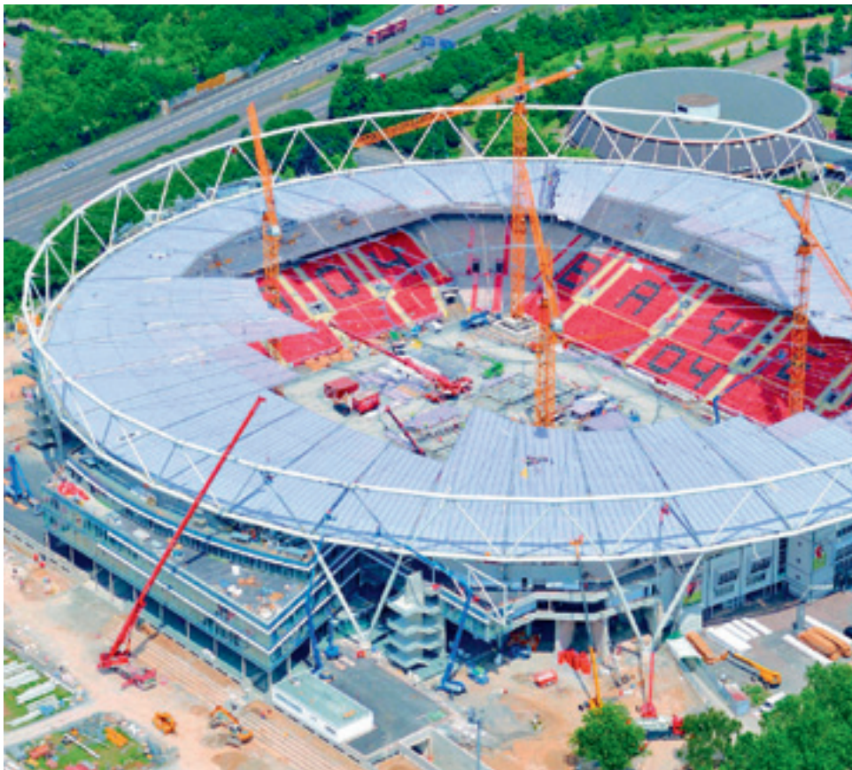
Die von der Köster AG modernisierte BayArena in Leverkusen
