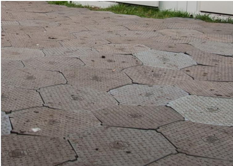
Abb. 10: Sechseckplatten „Spezial“ (Fa. UmTech) zwischen Bürocontainern (Günterberg, 2013)
