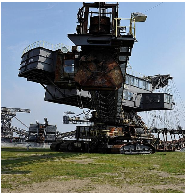
Abb. 54: MELT! Aufnahmestelle I (Mai 2013)
