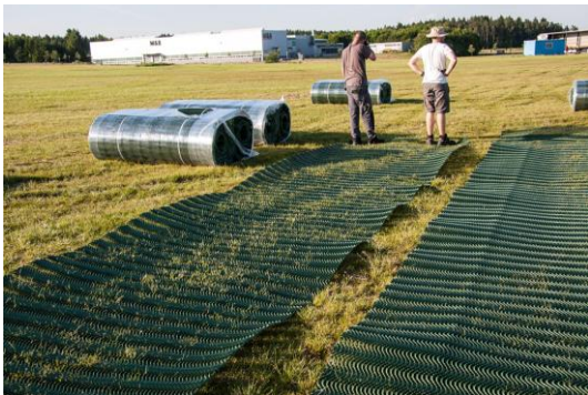
Abb. 63: Rasenschutzsystem „Grassprotecta“, Fa. Fiberweb, Leipzig (Günterberg 2013)
