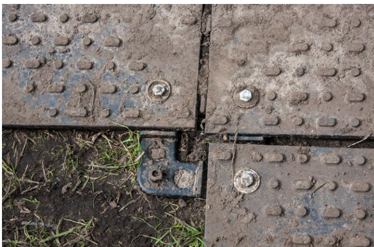
Abb. 9: „EuroMat“ – Bodenschutzplatten mit Schraubverbinder (Güntherberg, 2013)
