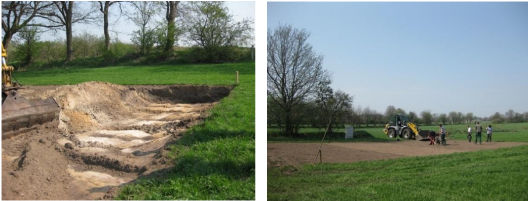
Abb. 24: Ausheben der Versuchsfläche (links), Einbau der Bodenmischungen (rechts)
