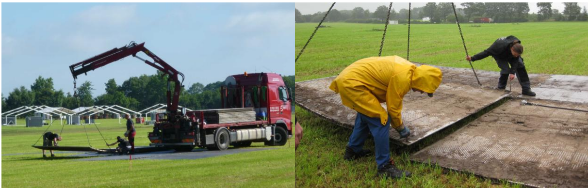
Abb. 11: Verlegung von Aluminiumplatten (Juli 2013)
